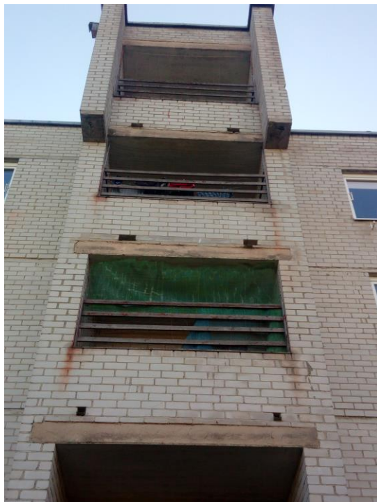
8 pav. Laiptinės balkonai
