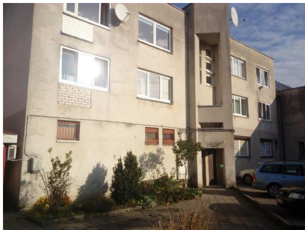
1 pav. Priekinis fasadas
