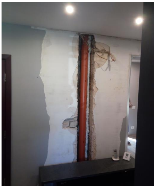
5 pav. Pakeisti vidiniai lietaus nuotekų vamzdžiai
